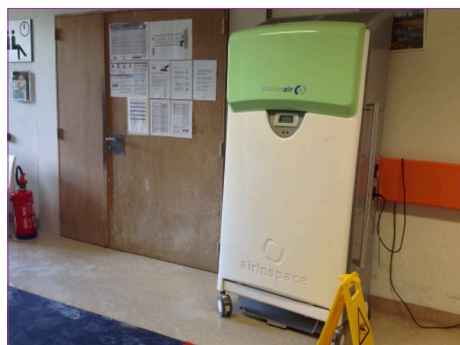
Figuur 30: checklist, plakmat en luchtdecontaminatietoestel aan een werf
